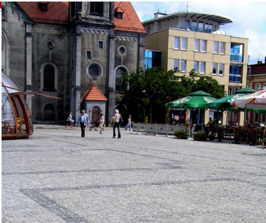
Kostka granitowa wraz z kostką sjenitową użyta jako dekor na Rynku w Tarnobrzegu
