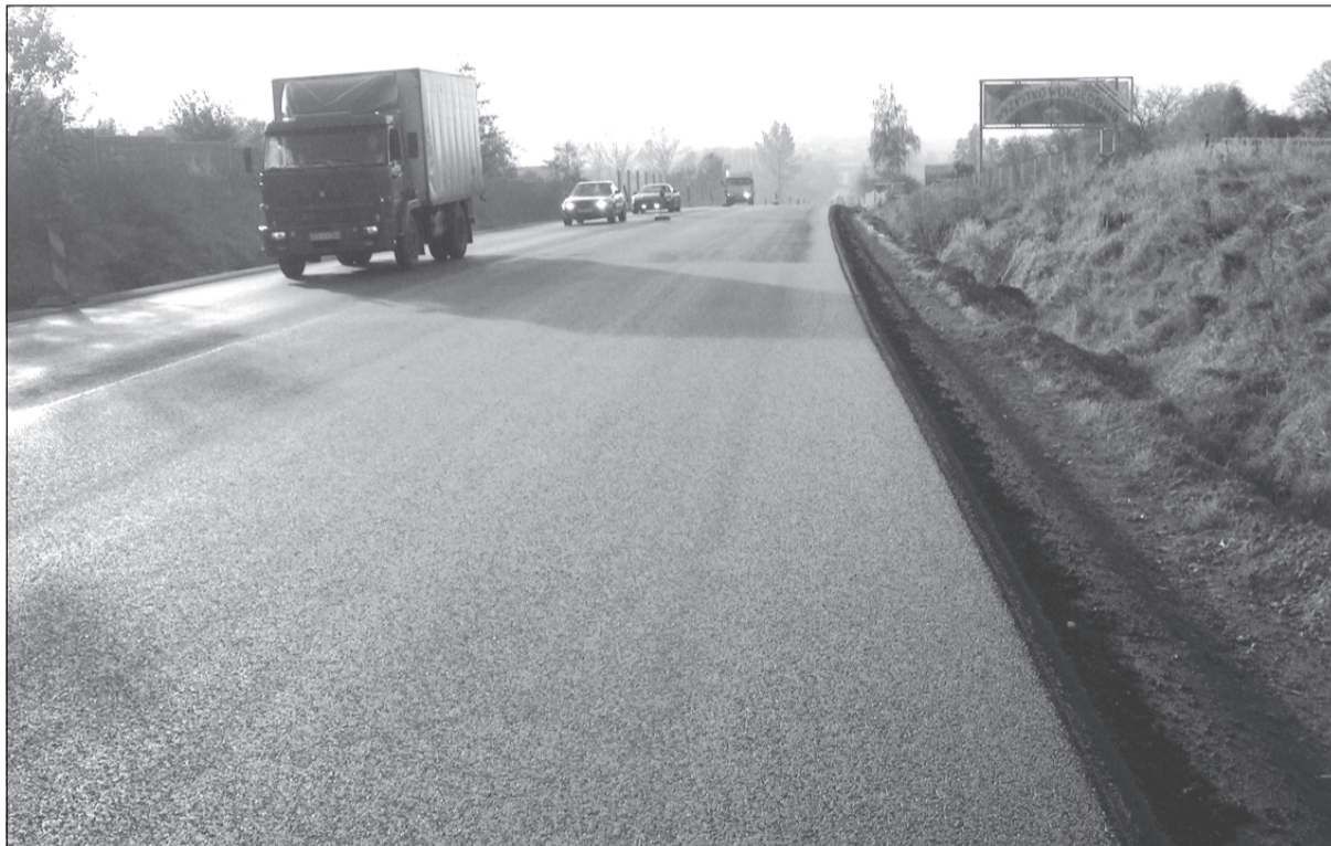
Kruszywa ze spółki Slag Recycling użyto m.in. do remontu modernizacyjnego drogi Kraków-Targowisko.
